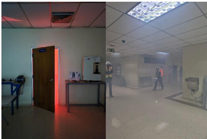
Ilustración 12: Conato de Incendio.
